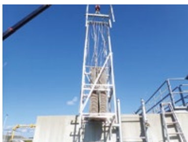
下水処理水路に熱交換器を設置
