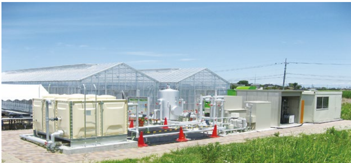
西川浄化センター
