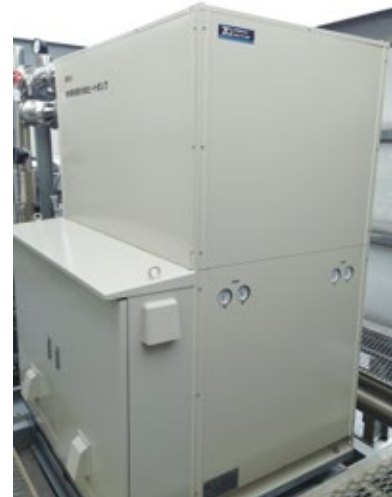
水冷式ヒートポンプチラー
