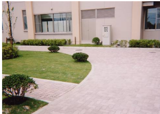
地中熱交換井を掘削した後の中庭(工事終了後)
