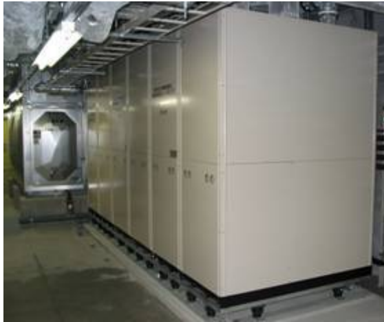
HRホテル様へ納入 水冷式ヒートポンプ
