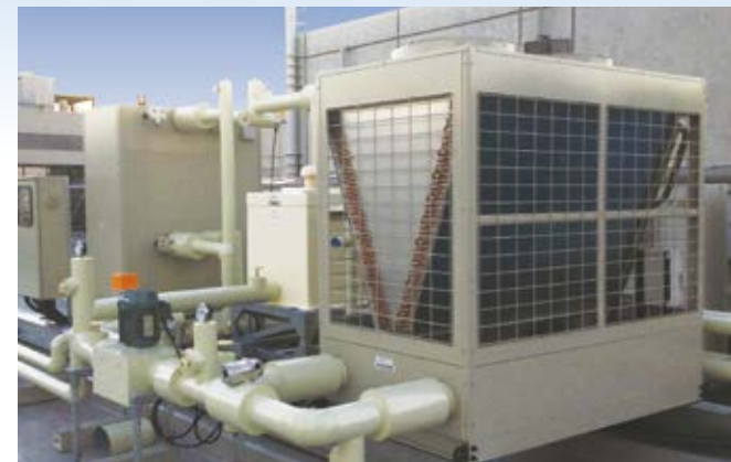
水-空気熱交換器
