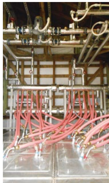
投げ込み式熱交換器ヘッダー
