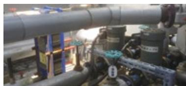
熱源ポンプとプレート式熱交換器
