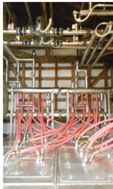
投げ込み式熱交換器ヘッダー
