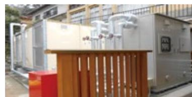
ヒートポンプ本体と貯湯槽（試運転時）
