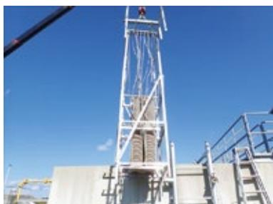
下水処理水路に熱交換器を設置
