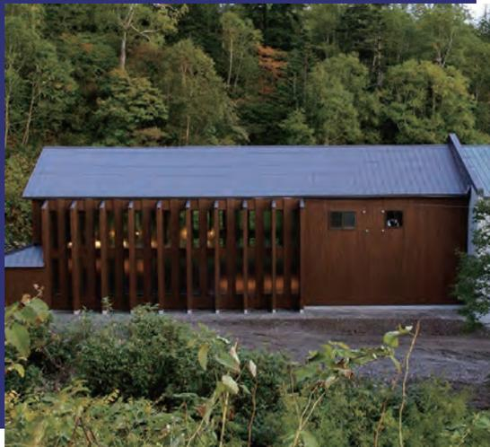
別館浴場「神々の湯」を設置するにあたり、クリーンなエネルギーを用いて自然に親しむ湯を提供するというコンセプトに基づき、熱源には電化システムを採用。夜間電力と温泉排湯熱エネルギーを積極活用しました。様々な取り組みによりランニングコストを当初計画（重油熱源）より約80%、CO<sub>2</sub>排出量については約60%の削減を実現しています。また、周囲への環境負荷を考え、新築ではなく既存の老朽化した木造建屋を改修利用。古いものの良さを残すことが環境保全にも繋がるものと考えました。こうした取り組みが評価され、当施設は、第7回日本環境経営大賞のCO<sub>2</sub>削減部門で優秀賞受賞をはじめ、様々な賞を受賞いたしました。
