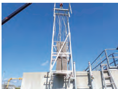
下水処理水路に熱交換器を設置
