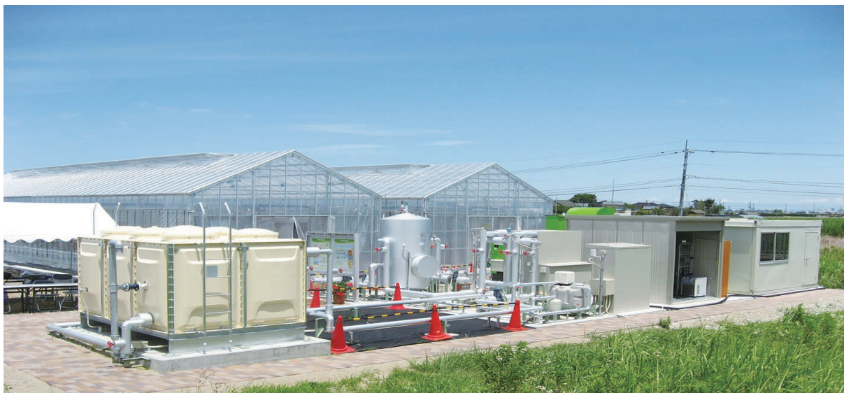
西川浄化センター
