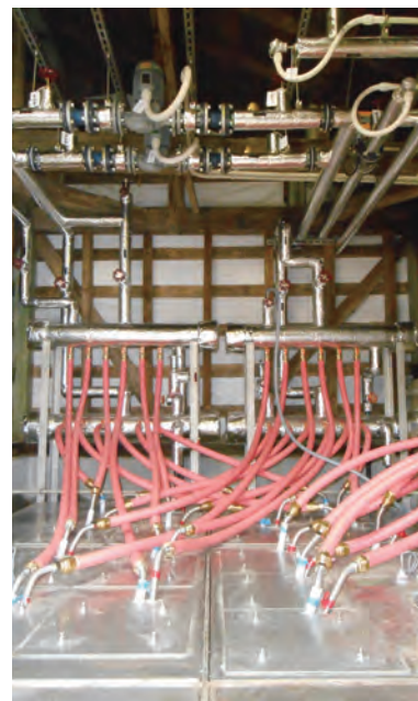
投げ込み式熱交換器ヘッダー
