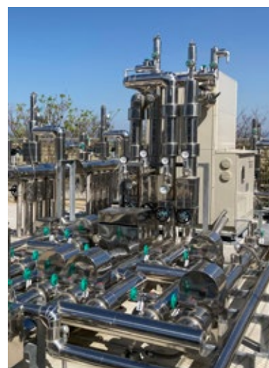
水冷式ヒートポンプチラー外観
