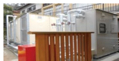
ヒートポンプ本体と貯湯槽（試運転時）
