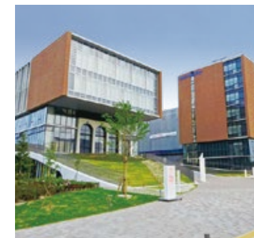
名城大学ナゴヤドーム前キャンパス 様 (愛知県名古屋市中区) 地 中 熱 地下水熱 水冷式ヒートポンプチラー(空調・氷蓄熱)
