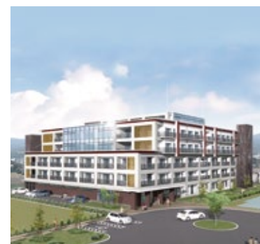
特別養護老人ホーム オー・ド・エクラ 様 (宮城県仙台市) 地 中 熱 水冷式ヒートポンプチラー(空調・給湯)
