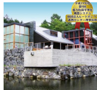
星のや 軽井沢 様 (長野県軽井沢町) 地 中 熱 温泉排湯熱 地下水熱 水冷式ヒートポンプチラー(空調・給湯・床暖房・氷蓄熱)
