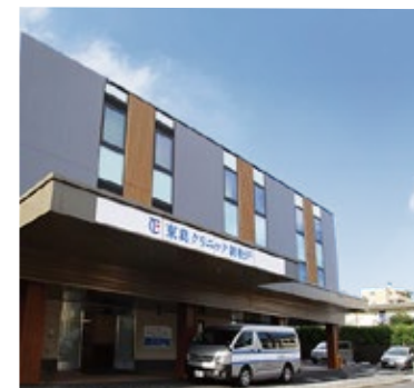
医療法人財団 松園会 東葛クリニック新松戸 様(千葉県松戸市) 透 析 熱 透析熱回収ヒートポンプシステム(加熱)
