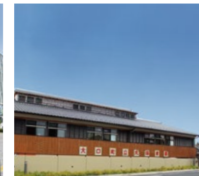
大口町立北保育園 様 (愛知県丹羽郡大口町) 地下水熱 空水冷式ヒートポンプチラー、空水冷式ビル用マルチシステム(空調・床暖房)
