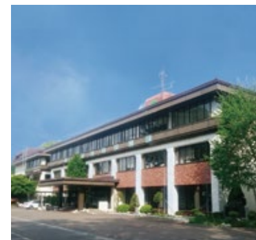
軽米町役場 様 (岩手県九戸郡軽米町) 地 中 熱 地下水熱 水冷式ヒートポンプチラー(空調・蓄熱)
