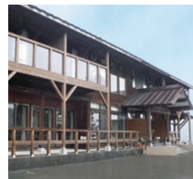
かのせ温泉 赤崎荘 様 (新潟県阿賀町) 温泉排湯熱 高温型水冷式ヒートポンプチラー、空水冷式ビル用マルチシステム、(空調・給湯)
