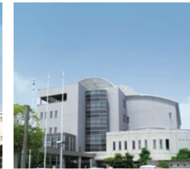
西尾市総合福祉センター 様 (愛知県西尾市) 地下水熱 高温型水冷式ヒートポンプチラー、水冷式ヒートポンプチラー(空調・給湯・氷蓄熱)
