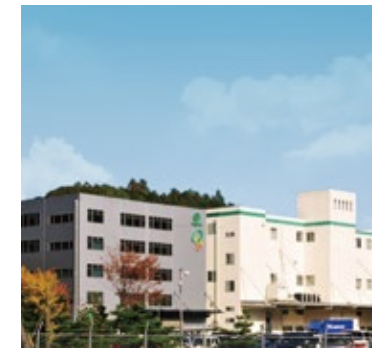
オンダ製作所 関工場 様 (岐阜県関市) 地 中 熱 水冷式ヒートポンプチラー、水冷式ビル用マルチシステム(空調)
