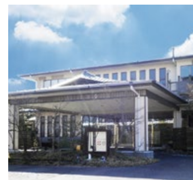
おとぎの宿 米屋 様 (福島県須賀川市) 温泉排湯熱 高温型水冷式ヒートポンプチラー(空調・給湯)
