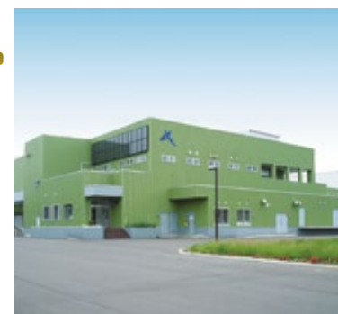
アレフ 北海道工場 様 (北海道恵庭市) 地 中 熱 排 熱 下 水 熱 水冷式ヒートポンプチラー、水冷式ビル用マルチシステム(空調・給湯・氷蓄熱)
