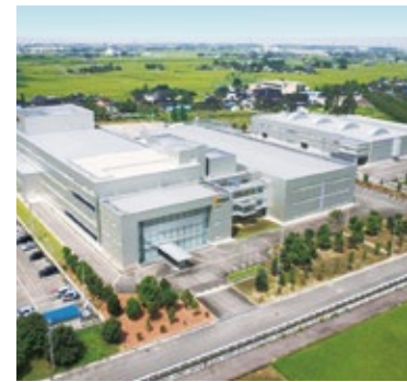
ファインクス株式会社 上条工場 様 (富山県富山市) 地下水熱 水冷式ヒートポンプチラー(空調・氷蓄熱)
