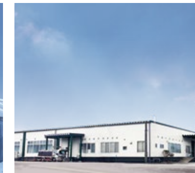
あしつきの森 様 (富山県高岡市) 地下水熱 水冷式ビル用マルチシステム(空調(しいたけ工場))
