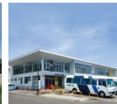
メルヘンスポーツ鹿屋 様 (鹿児島県鹿屋市) 地下水熱 高温型水冷式ヒートポンプチラー(空調・温水プールの加温)
