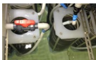
施工例：タンクに組み込んだ投込式熱交換器
