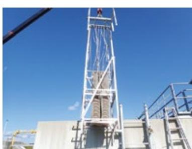
下水処理水路に熱交換器を設置
